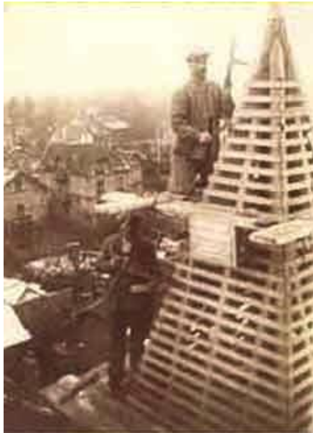
Clocher en construction
