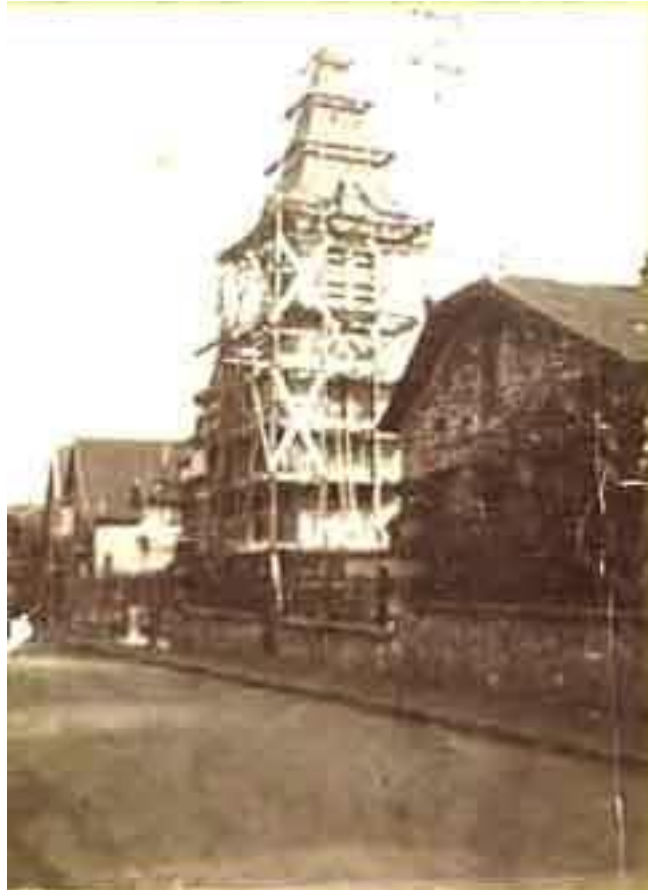
Clocher en construction
